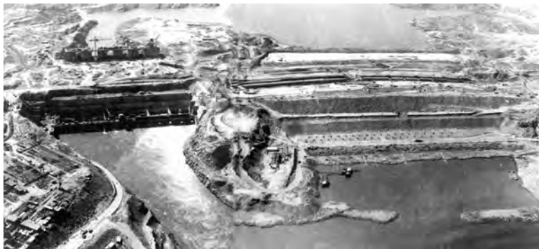
Асуанская плотина строится, вид с птичьего полета
