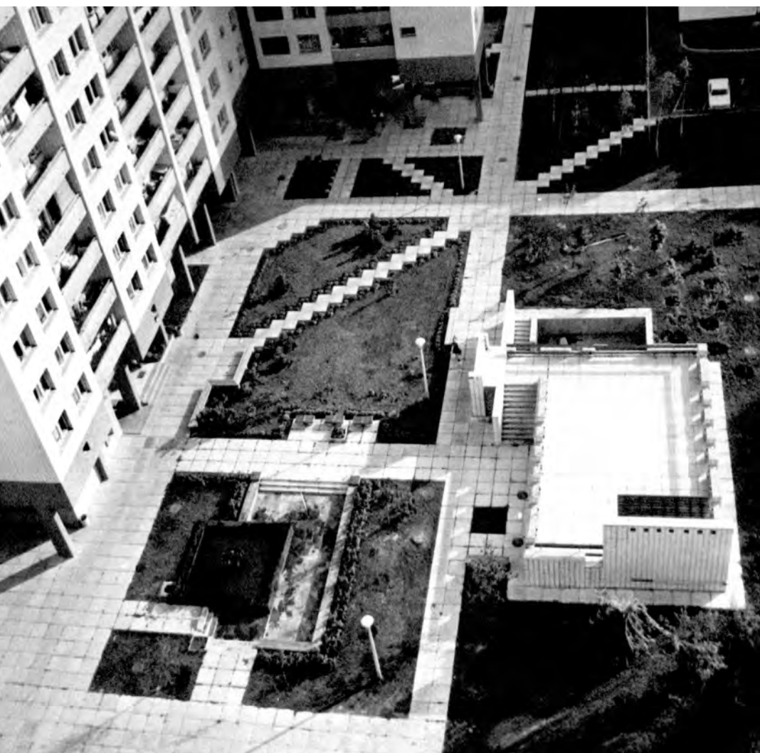
Жилой дом по ул. Суворова № 13
