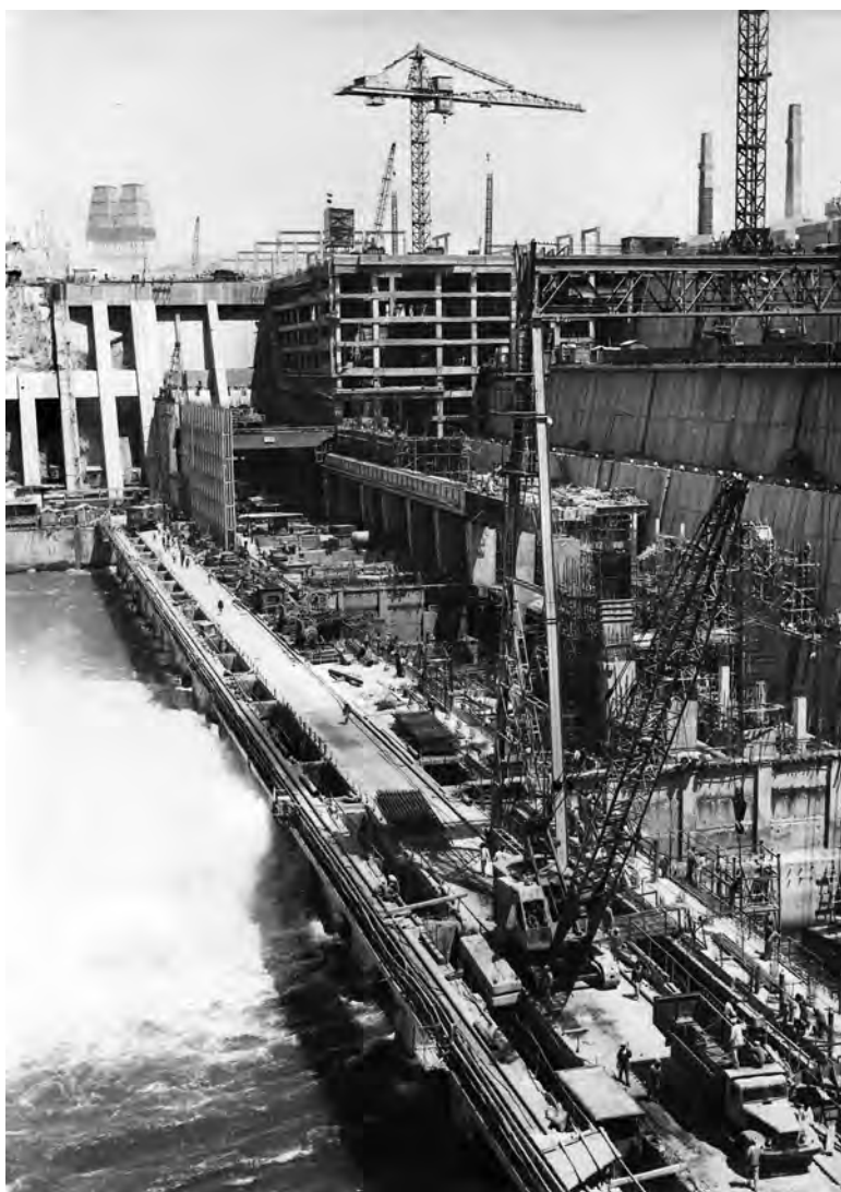
Строительство высотной Асуанской ГЭС, 1964–1968
