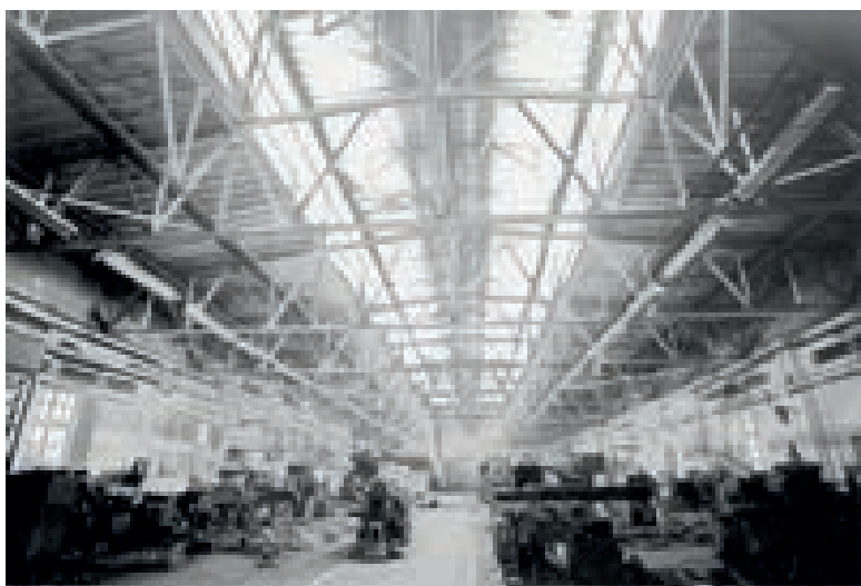
Київський арсенал, стан до реконструкції
