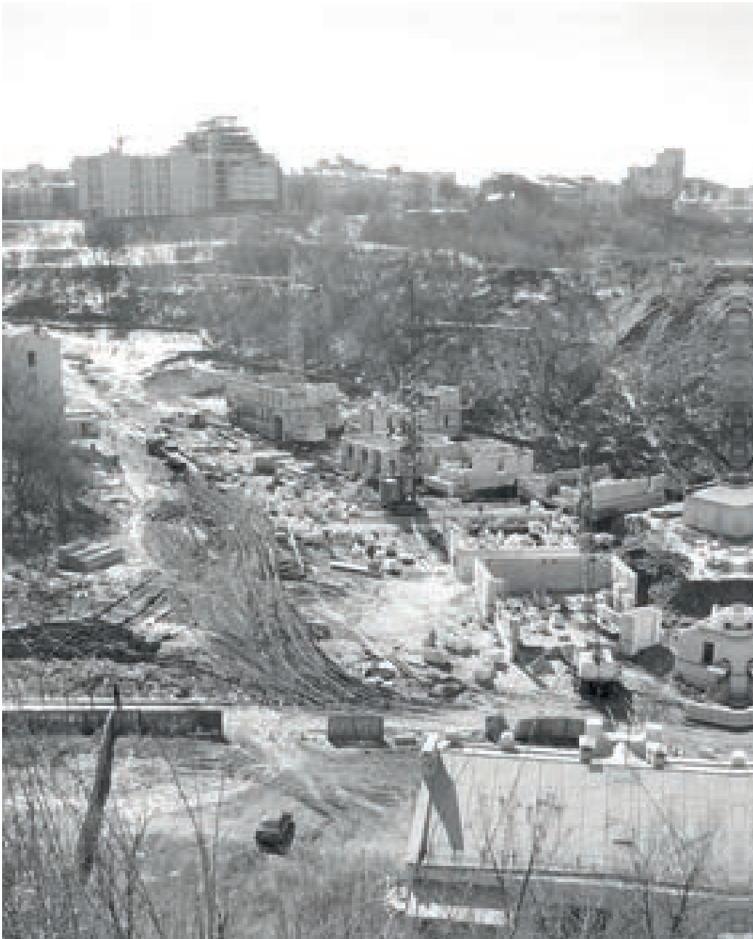
Строительные работы на ул. Гончарной, март 2004 года
