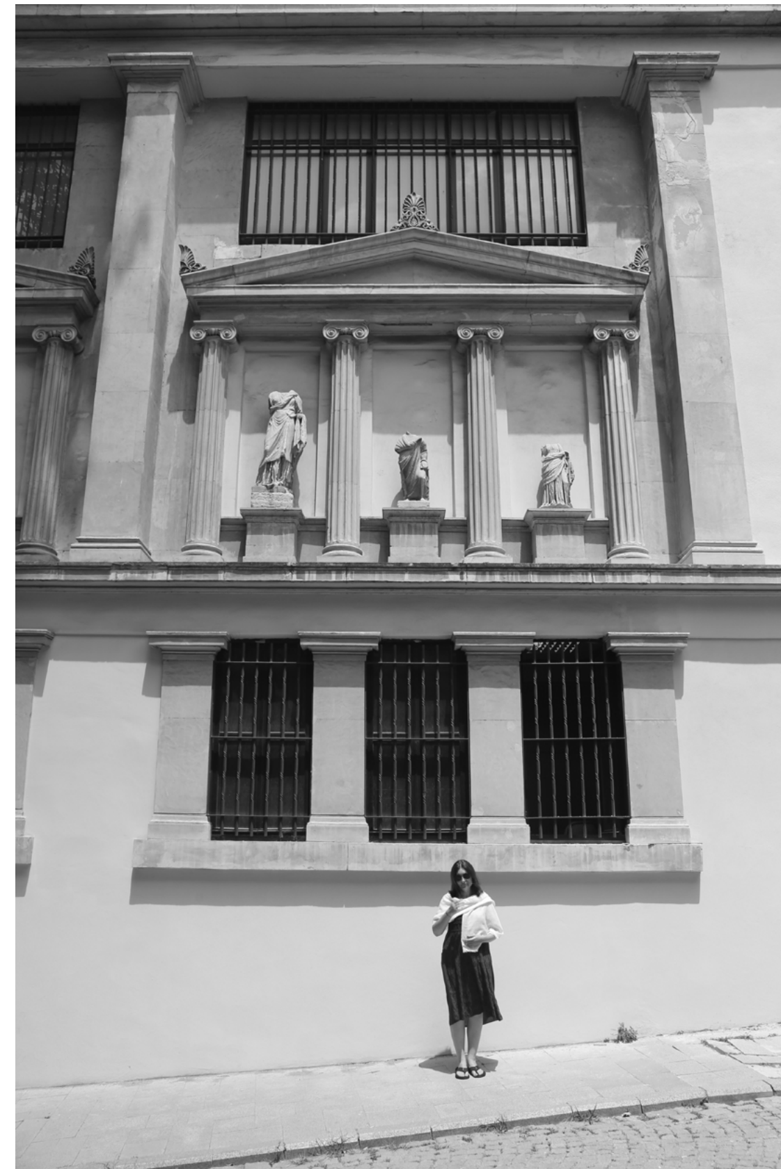
Западное крыло главного корпуса
