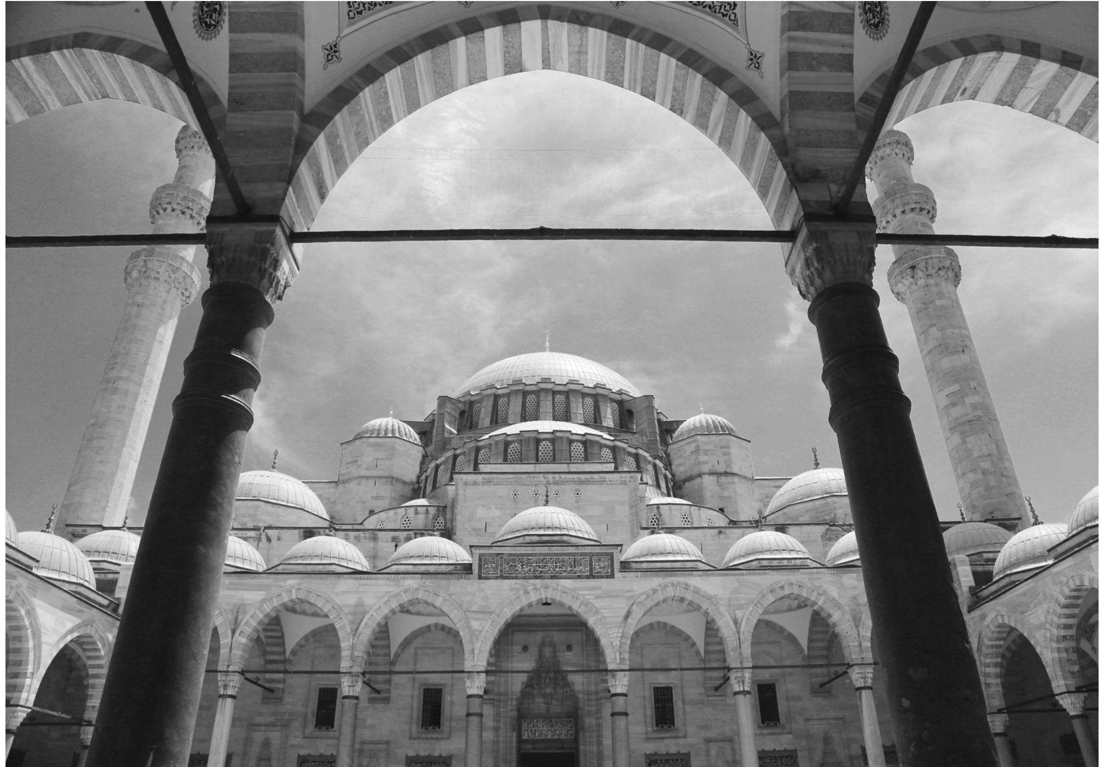
Западный фасад, вид с перистильного двора
