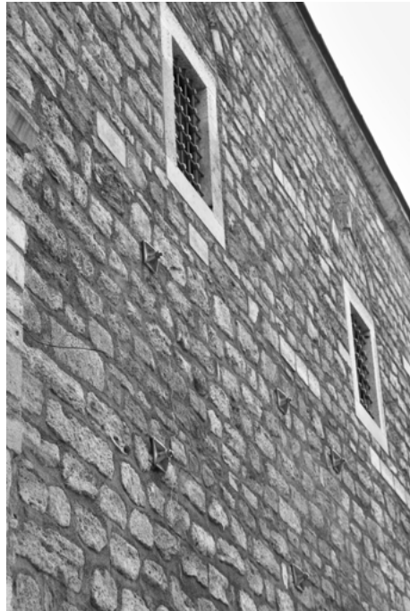
Внешняя стена комплекса
