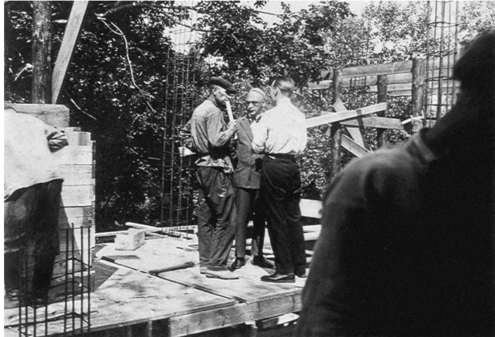
Мойсей Гінзбург (у тубетейці, ніжки пекарем) на будівництві житлового будинку на Новінському бульварі, фото 1932 року
